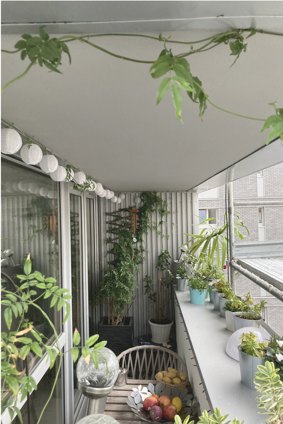
Une lisse de serrurerie est ajoutée au garde-corps maçonné afin de venir tirer parti de l'épaisseur ajouté en façade et permettre aux locataires d'y déposer des jardinières.
