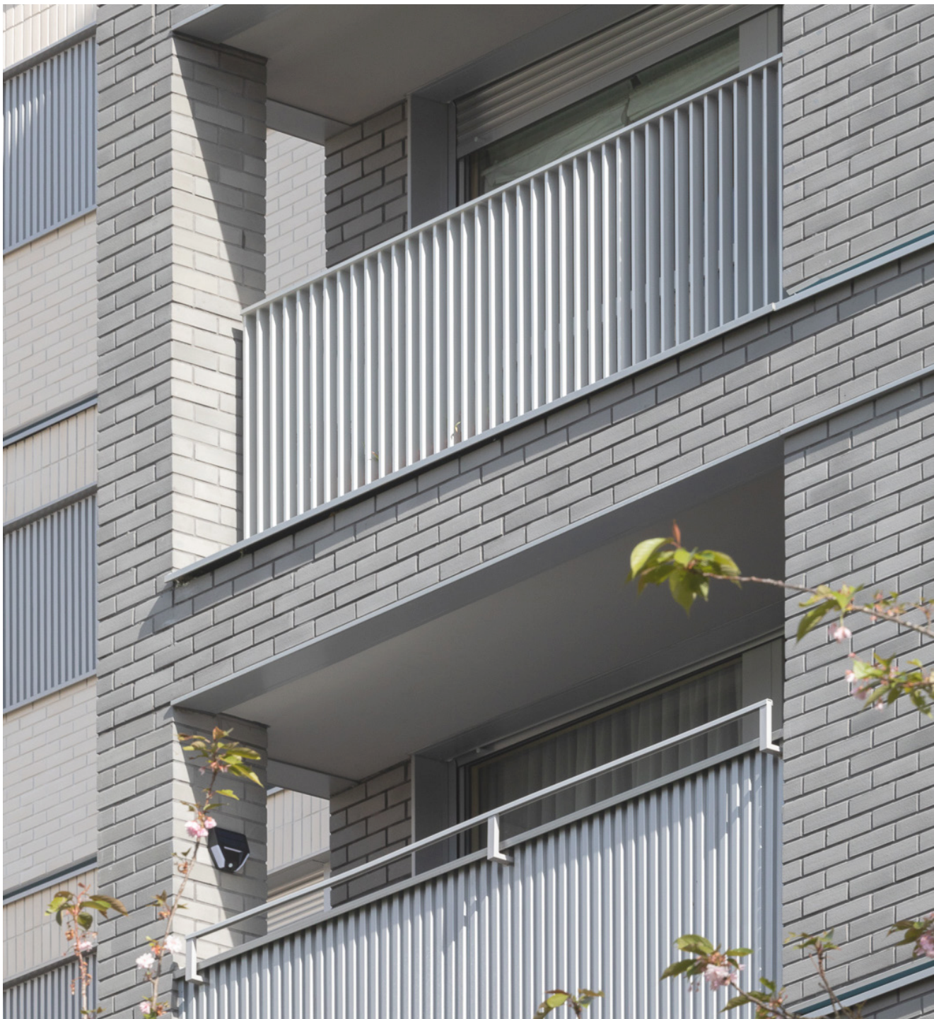
Détails - jeu d'alternance d'un garde-corps serrurier avec un garde-corps avec bardage aluminium nervuré.
