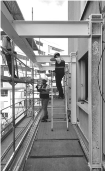
Montage des premiers niveaux de charpente des jardins d'hiver.
