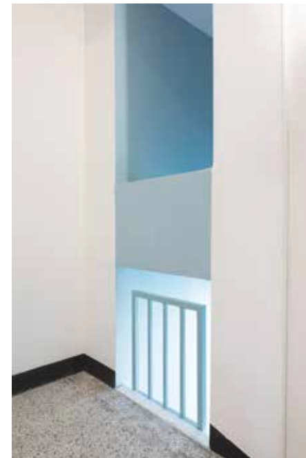
Création d'une ouverture à l'emplacement du vide-ordures pour éclairer naturellement les cages d'escaliers.
