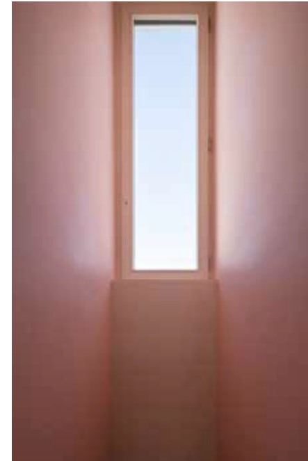
Création d'une ouverture à l'emplacement du vide-ordures pour éclairer naturellement les cages d'escaliers.
