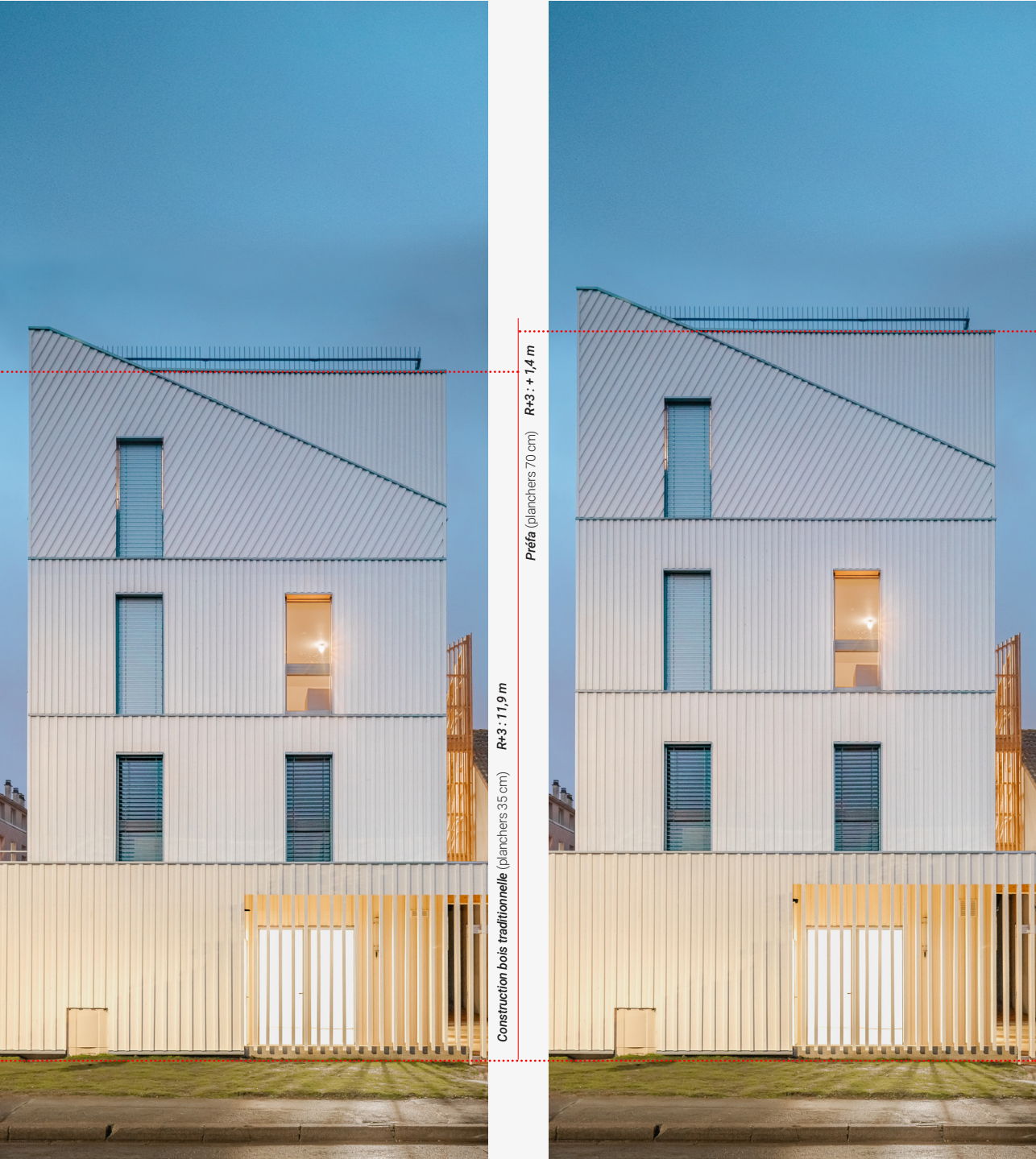
Construction sur place : l'acrotère est à 10,5 m. Les hauteurs d'étages sont usuelles
